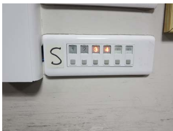
Cuadro de control de llamadas en Ilundáin, Aranguren
