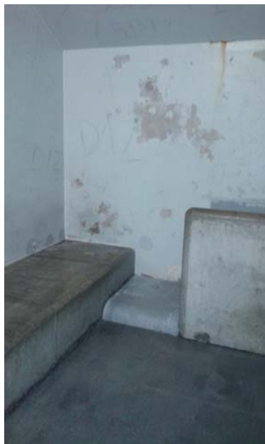
Aseos en el interior de una celda en la Comisaría de los Mossos d'Esquadra de Barcelona
